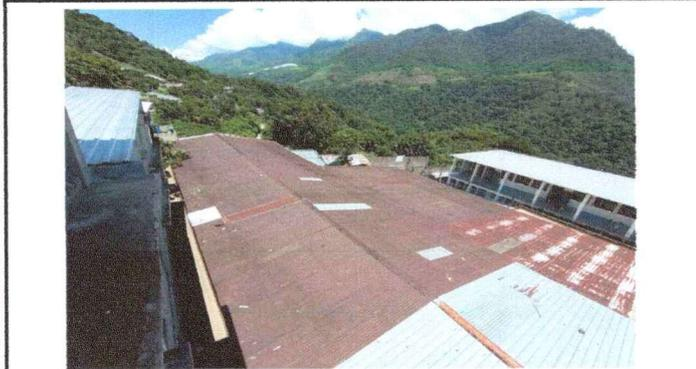
**Foto 1:** Estado de las láminas del módulo 1, que se encuentran oxidadas que ameritan sustitución.
