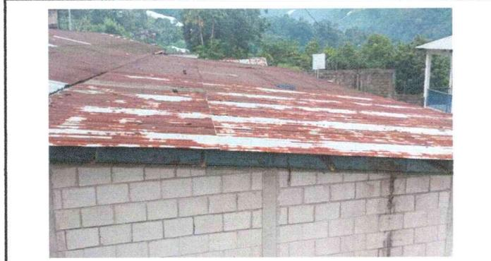
**Foto 3:** En esta fotografía se aprecia el estado de las láminas oxidadas que corresponden al módulo 2.
