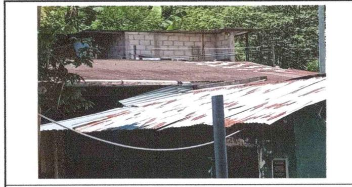
**Foto 5:** La cubierta de lámina del módulo 3 vista desde otro ángulo, que amerita la sustitución.
